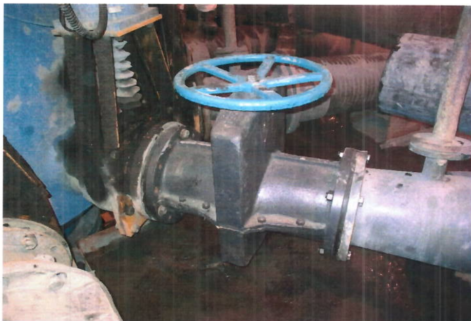
Рисунок 1 – фото установленного клапана пережимного « МЕТАРОССА PL-MSN DN-250 PN10 »
